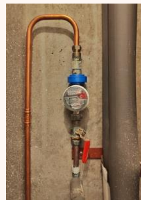
De warmwatermeter in het toilet
