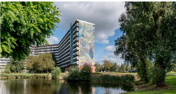
Kopgevel Hakfort met vijver
